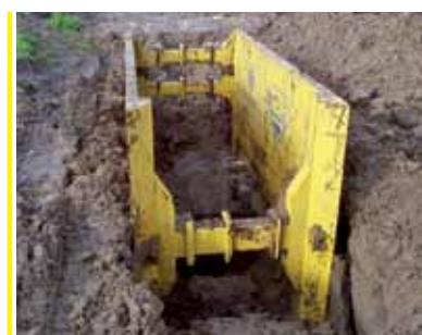
Paneli  $t_{PL} = 127\text{mm}$
